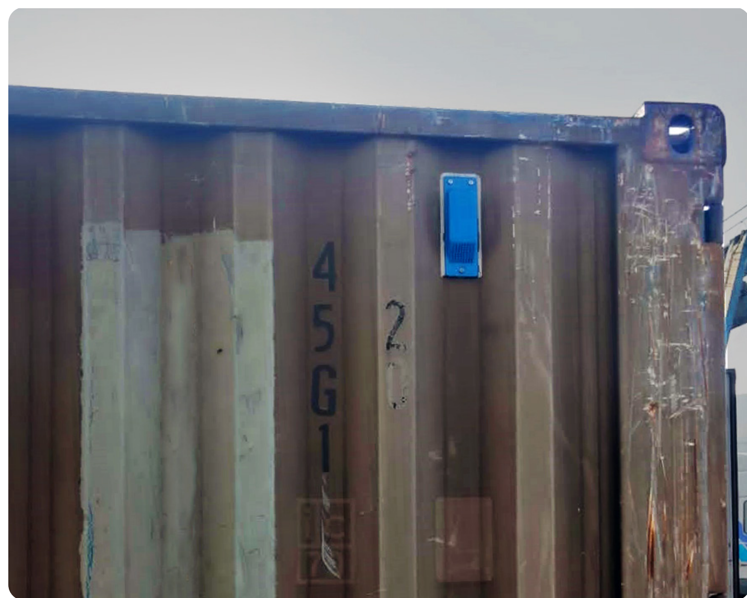
КОРПУС С ТЕЛЕМАТИЧЕСКИМ ОБОРУДОВАНИЕМ ВНУТРИ, ЗАФИКСИРОВАННЫЙ НА СТЕНКЕ ГРУЗОВОГО КОНТЕЙНЕРА
